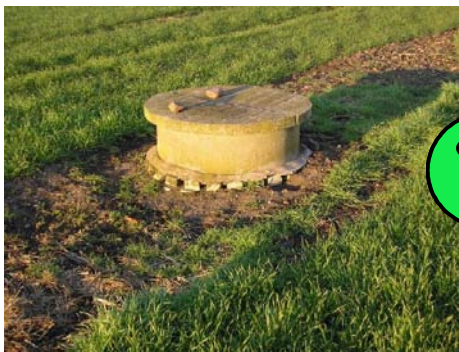
Fig. 32 – Pozzo adeguatamente protetto (foto Harper Adams).
