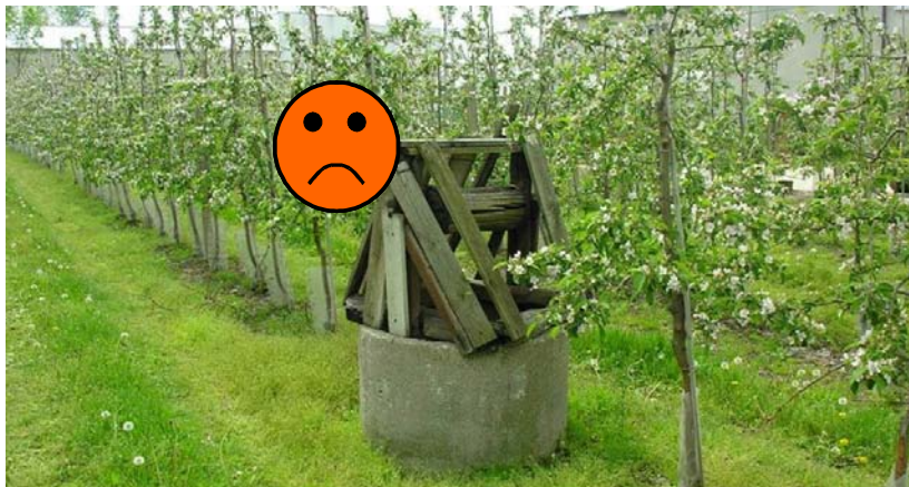
Fig. 73 – Pozzo non adeguatamente protetto (Foto ISK)
