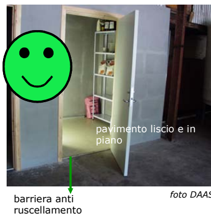
Fig. 28 – il locale per lo stoccaggio degli agrofarmaci deve essere dotato di pavimento liscio e non scivoloso.
