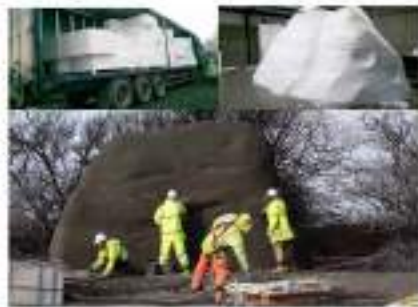
Processo di montaggio dei boulders
