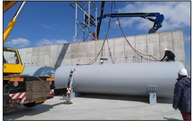
Foto 3: Installazione Serbatoi (©: Chiara Tripodi)
