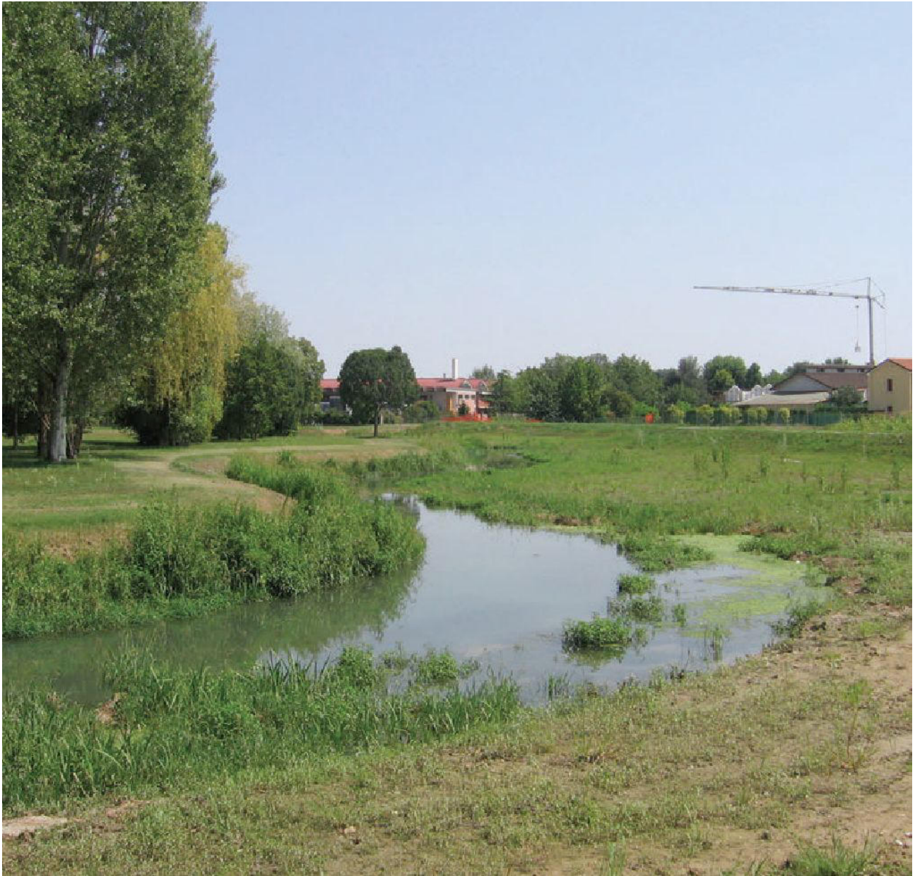
Fig. 5 (da Caggianelli et al., 2010): Creazione di una golena a due stadi. La sponda destra del canale è stata arretrata mediante sbancamento dell'area retrostante, sino a creare una golena suddivisa in due livelli differenti e progettata per essere allagata parzialmente con piene ordinarie e totalmente con piene straordinarie; queste vengono contenute grazie alla costruzione di un nuovo argine (a destra nella foto), arretrato rispetto al ciglio di sponda originario. (Foto: Consorzio di bonifica Acque Risorgive)
