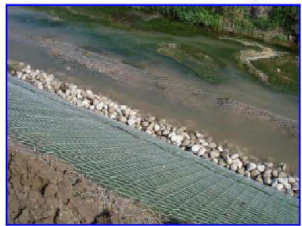
Fig. 10: Schema di posa di rete metallica anti-nutria ed anti-gambero ed esempio di posizionamento (Canale Molinella, Comune di Castiglione Mantovano). Una volta messa in posto, la rete è ricoperta con uno strato di suolo e non sarà più visibile, ma permetterà lo sviluppo della vegetazione.
