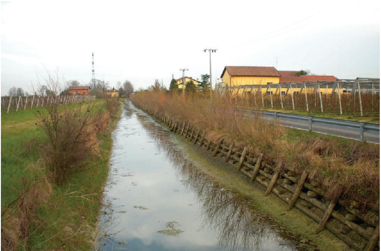
Fig. 9 (da Caggianelli et al., 2010): Aspetto di una palificata rinverdita nel periodo autunnale, dopo qualche anno dalla fine dei lavori: si noti lo sviluppo degli astoni di salice sulla sommità della palificata, a ridosso della strada, che andranno a svolgere sia funzioni di tipo naturalistico che di tipo stabilizzante. Sulla sponda opposta è stata definita una fascia di mobilità.
