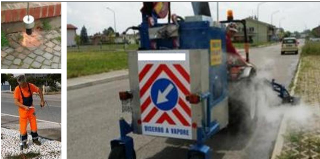
Figura 1. Esempio di pirodiserbo e diserbo a vapore, ovvero di metodi non chimici di controllo della vegetazione infestante
