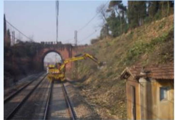
Viene eseguito con motocarrelli ferroviari dotati di frese trincianti. La produzione media di queste attrezzature è di circa 1.000 m/h. Il tempo medio di intervento su una linea principale è inferiore ad un ora al giorno.
